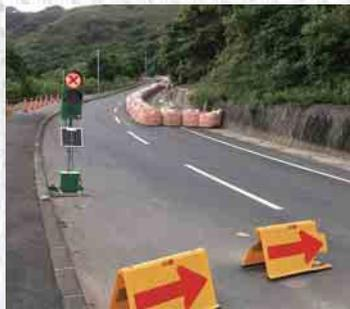
被害の大きかった県道は仮復旧し片側通行により運用中(伊砂～伊実久、10月1日撮影)
