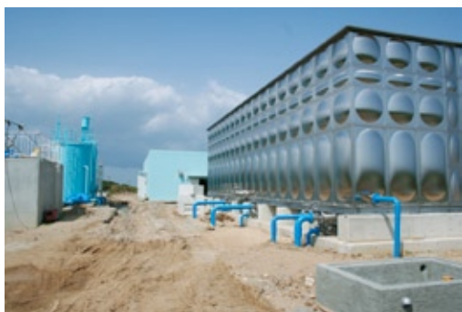
年度内一部供用開始予定の南部地区浄水場
