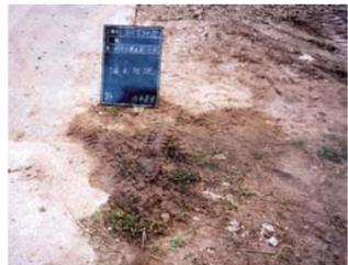
写真：漏水でぬかるんだ道路わずかに表出した水量も地下ではかなりの量と思われます。
