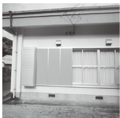
改修工事済の大朝戸公民館
