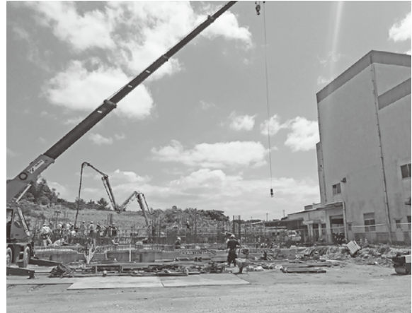
建設が進む、新クリーンセンター今年度完成予定
