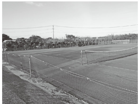
台風被害で破損したテニスコートの修繕 (湾町グラウンド上)
