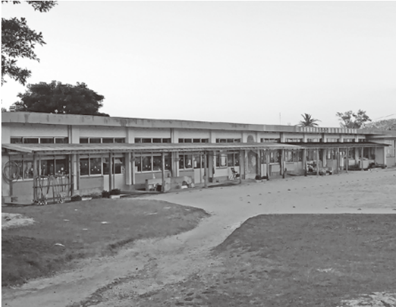
昭和45年に建てられた保育園老朽化により建て替え
