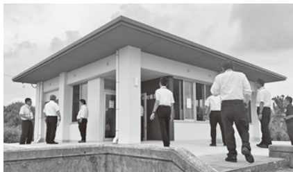
港湾整備事業 老朽化により待合所の建て替え（早町港）
