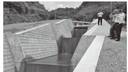
農業用施設災害普及事業 災害に備え水路を拡張（伊美久阿丸地区）
