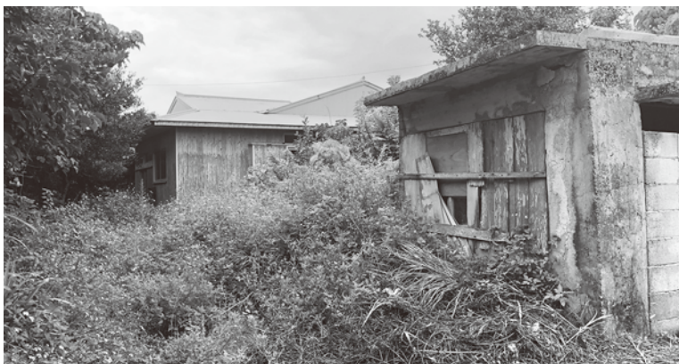
空き家になっている住宅
