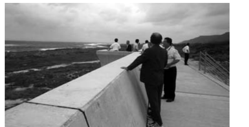
県営海岸保全施設整備事業(白水堤防工事)
