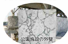
公園施設の外壁
