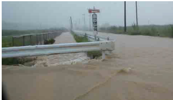
▲濁流による冠水
