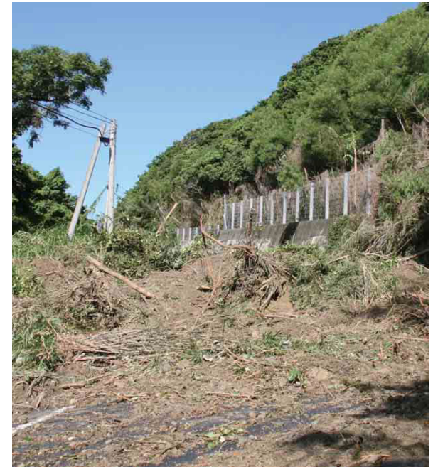
▲土砂崩れで塞がれた道路 出典:広報きかい
